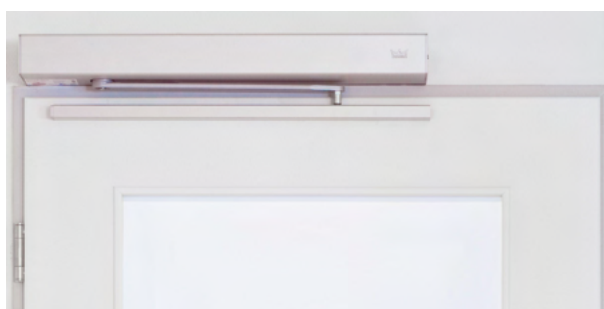
Figur 5.12: Dørautomatik: Dormakaba ED100. Denne automatik lever op til de krav der gør de ønskede funktioner mulige. Den nyeste eksisterende toiletmodel har samme automatik installeret og alt tyder på at den kan tilpasses tilstrækkeligt til systemet.
